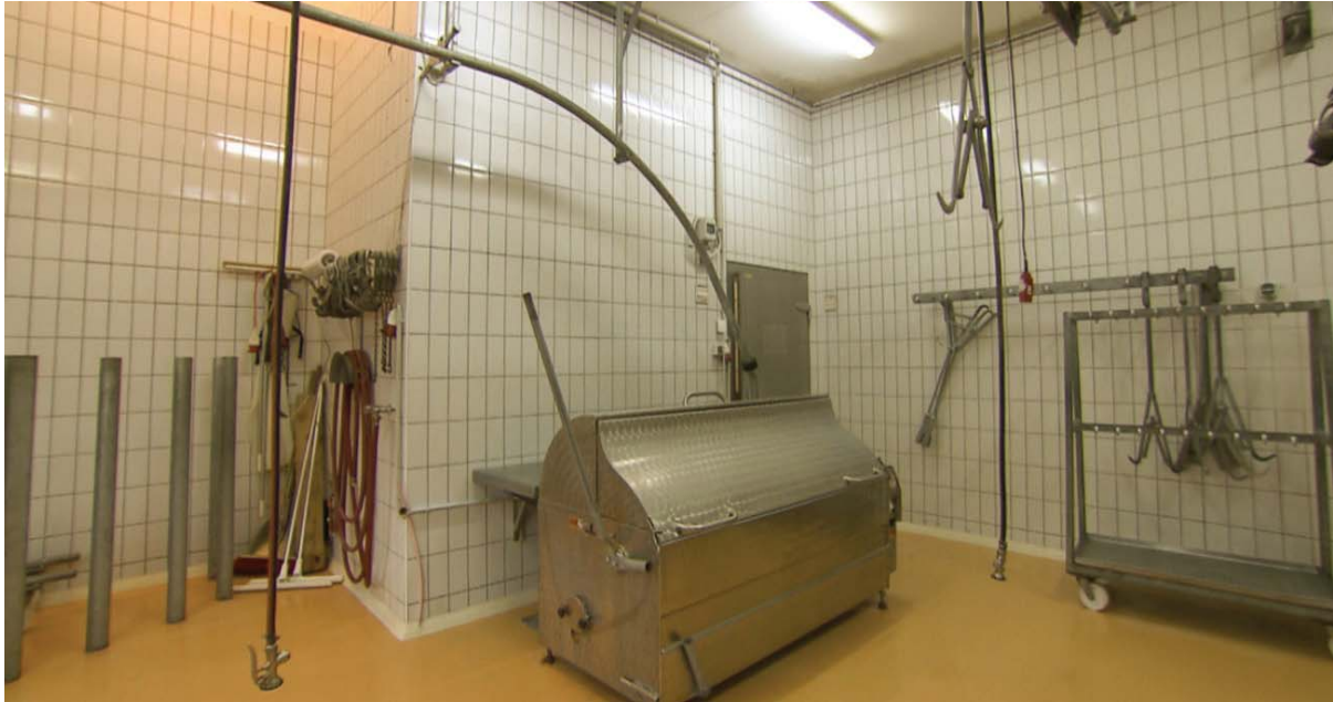
Bild 7: Bauliche Ausführung und Ausstattung von Schlacht- und Verarbeitungsräumen hängen ab von Art und Umfang der Produktion. © LFI, Bernhard Raab
