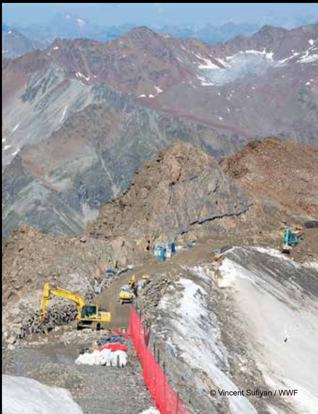
Bauarbeiten im bestehenden Skigebiet am Pitztaler Gletscher.
